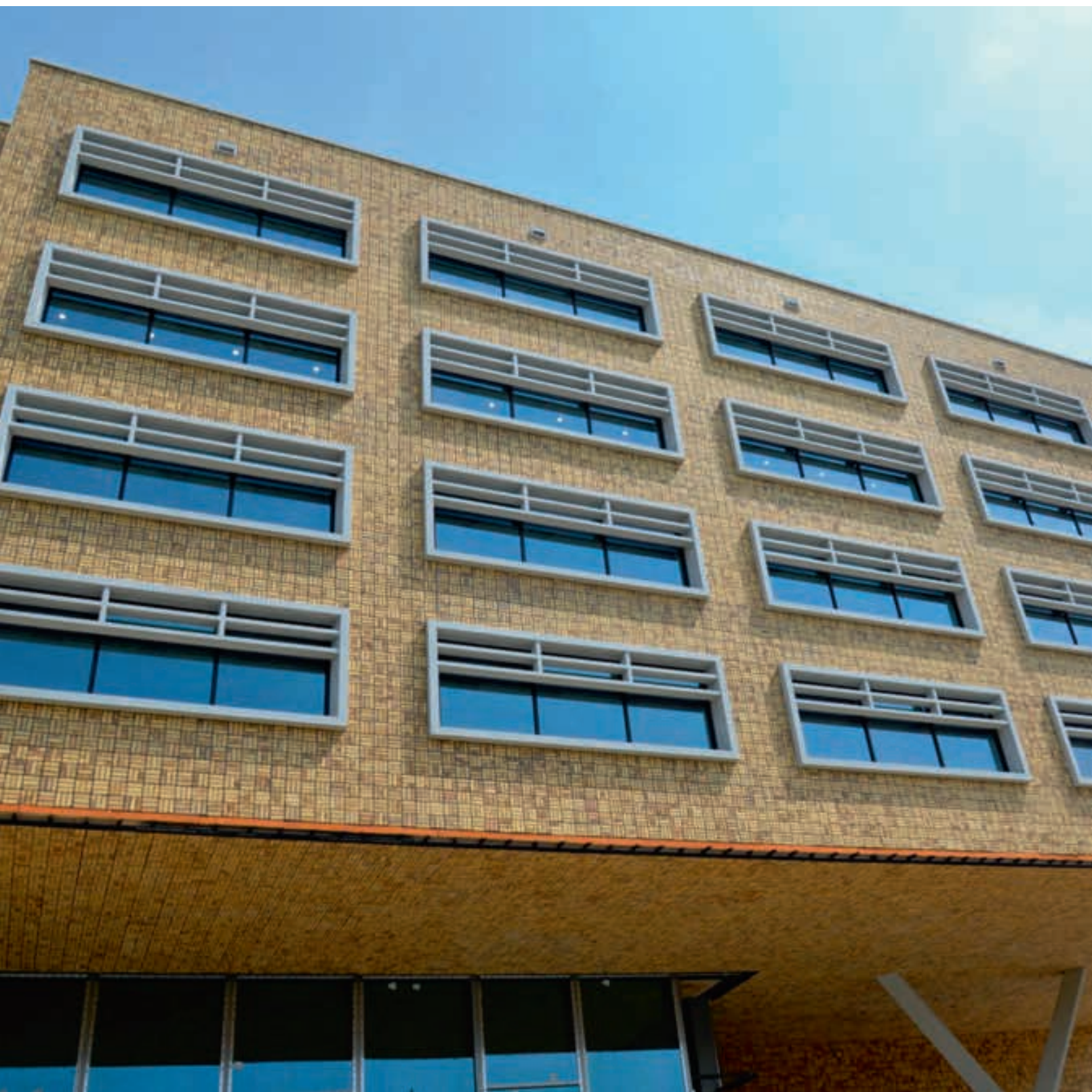
Sussex Multi Gesinterd Fuss SP Havenlaan, Brussels
